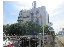
産廃焼却炉 令和8年8月21日時点 現在の所、人の出入りはあるが解体工 事の気配は見られない
